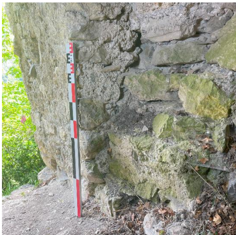
Figure 115. Piédroit sud P4, notez la pierre taillée en tuf de l'encadrement de l'entrée d'origine. Crédit Florence Guillot.
