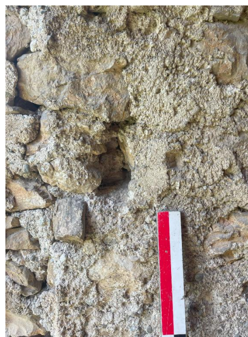
Figure 146. Enduit et mortier dans le couloir P4. Possible empochement d'un gond disparu. Crédit Florence Guillot.
