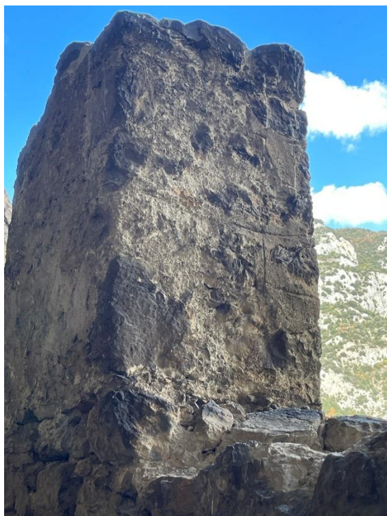
Figure 192. Merlons reconstruits en phase 2-2-8. Joints tirés à la pointe. Crédit Florence Guillot.
