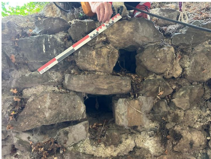
Figure 125. Empochement 11 façonné (en haut) et 6 (maçonné dans M5a) en bas. Crédit Florence Guillot et Denis Langlois.
