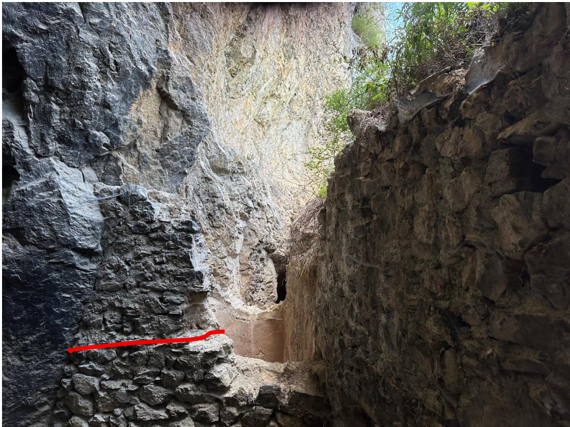
Figure 150. Passages en haut du M6 (devant) et du M15 (au fond), contre M5 (à droite). En rouge le coup de sabre entre M6a (en haut, vestige de cit1) et M6b (en bas, reconstruction en spoulga 1-3). Crédit Florence Guillot.
